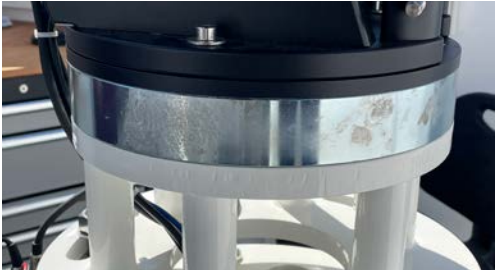
Normale Alterung: Ein galvanisierter Edelstahlflansch nach einem Jahr in einer belüfteten, unklimatisierten Klappdachhütte. Das Material wird durch Umwelteinflüsse irgendwann vollständig matt, rostet aber nicht.
